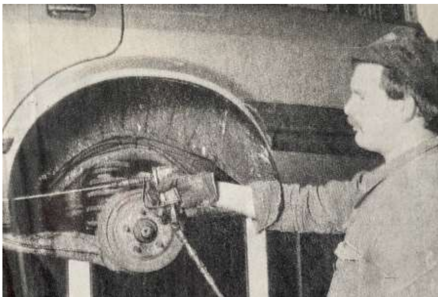
Bild 65. Från tidning 120 okt 1992 sid 19. Timo Wargh talar om att man inte får fuska varken med rengöring, torkning eller, som här, med insprutning i balkar. Fortfarande 2023 jobbar Timo kvar på firman. Foto: Okänd.
