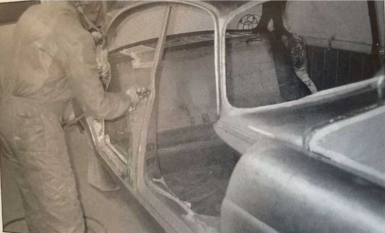
Bild 30. Från tidning 116 feb 1992 sid 28. Mk X:an gjordes plåtren och primemålades därefter före uppspackling. Foto: Bengt Alm.
